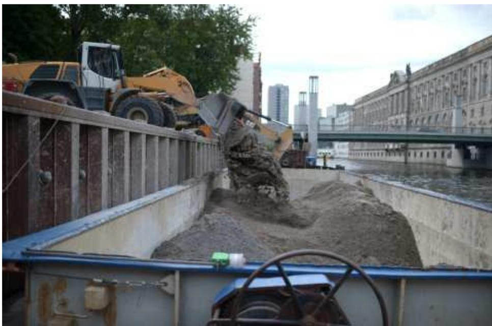
Le plus long chantier de Berlin : dans le centre-ville, ce qui est retiré du chantier de la ligne n°5 est chargé sur l'«Ednand». Proche du mur du quai, au forum Marx-Engels, se trouve l'entrée du puits au fond duquel opère la foreuse qui va permettre de creuser sous la Sprée et de rejoindre la Brandenburg Tor.
