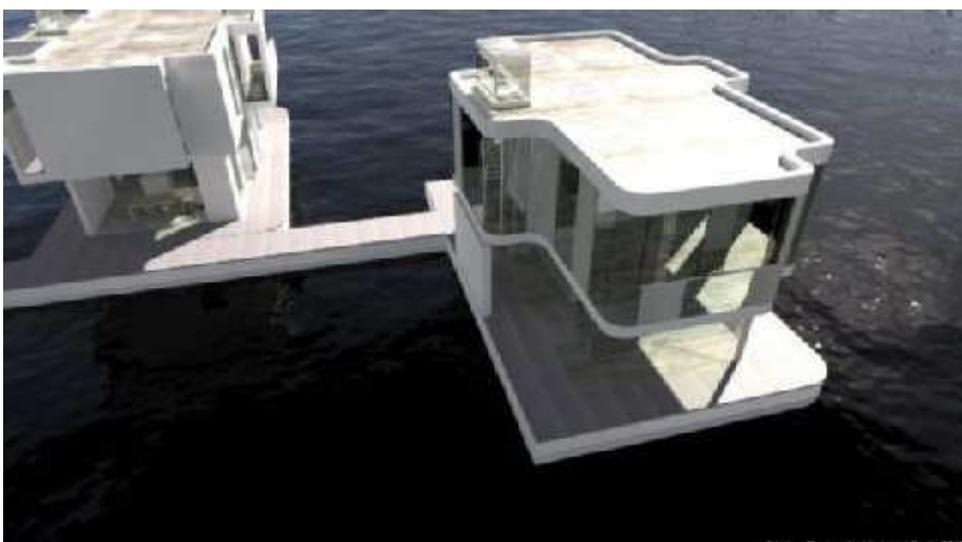
Les lofts flottants doivent être posés sur des pontons en béton flottants dans la presqu'île de Stralau.
