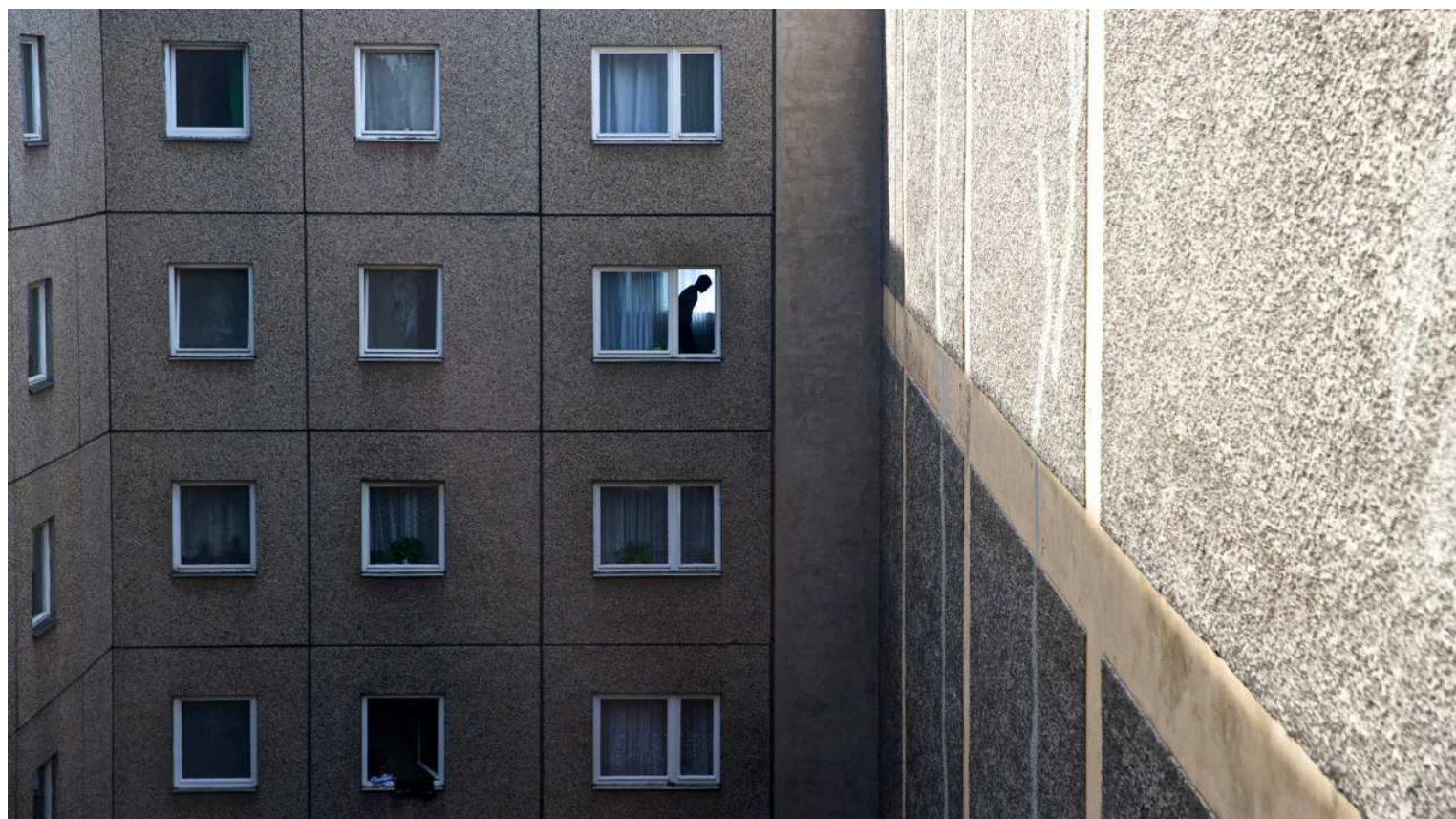
Un être solitaire entre béton et mur pare-feu Foto : Johannes Groß
