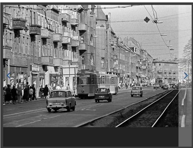
En septembre 1990, un tramway de la ligne 26 circule sur la Wilhelmshofstraße à Oberschönenweide. imago
