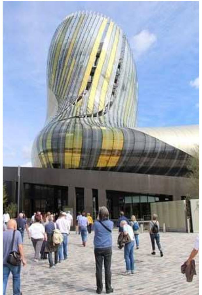
Visite de la cité du Vin à Bordeaux
